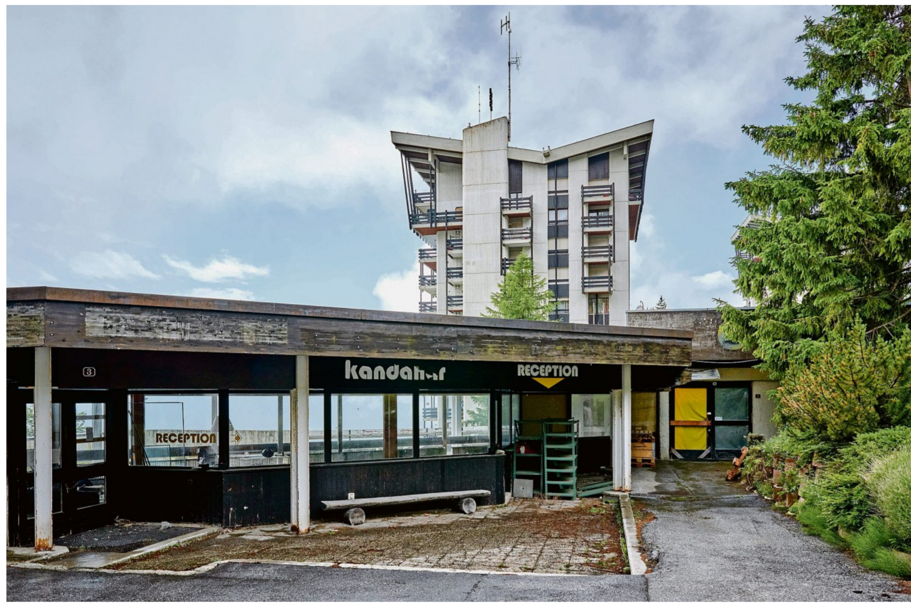
Wucherndes Unkraut, abblätternde Schriften, leere Ladenflächen – und im Hintergrund die Wohntürme aus den Siebzigern: Das verwahrloste Resort Aminona bei Crans-Montana.
